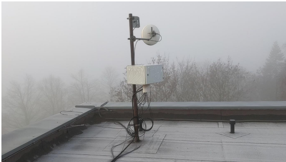
Foto pavilon C (detail antény vpravo a dále vedení optického kabelu podél jihozápadní atiky)
